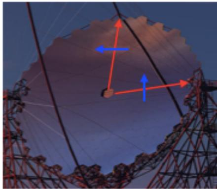
図 6.3: 放物面上での  $\rho_r$  をとる方向 (赤線) と  $\rho_p$  をとる方向 (青線) を示している。
